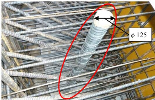
写真-1 中空材設置状況（側壁 1リフト）
