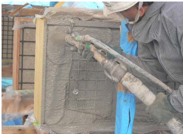
図-2 吹付けの状況
