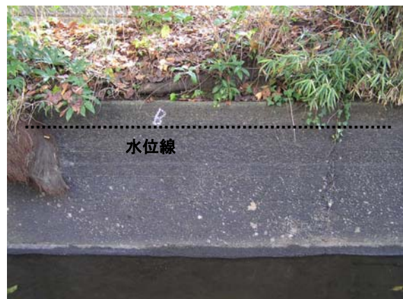
写真 - 3 コンクリート水路表面 （通常部、昭和 38 年改修）
