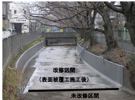
写真 - 2 補修後の計測対象水路
