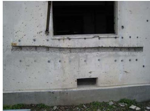
写真-2 はつり調査の状況
