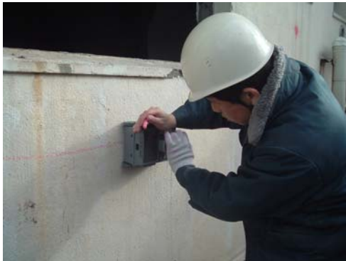
写真-1 非破壊試験の状況
