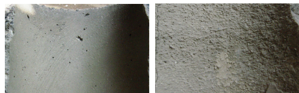
a. 未処理 b. 粗面化 写真-1 引き抜き成型による貫通孔の表面
