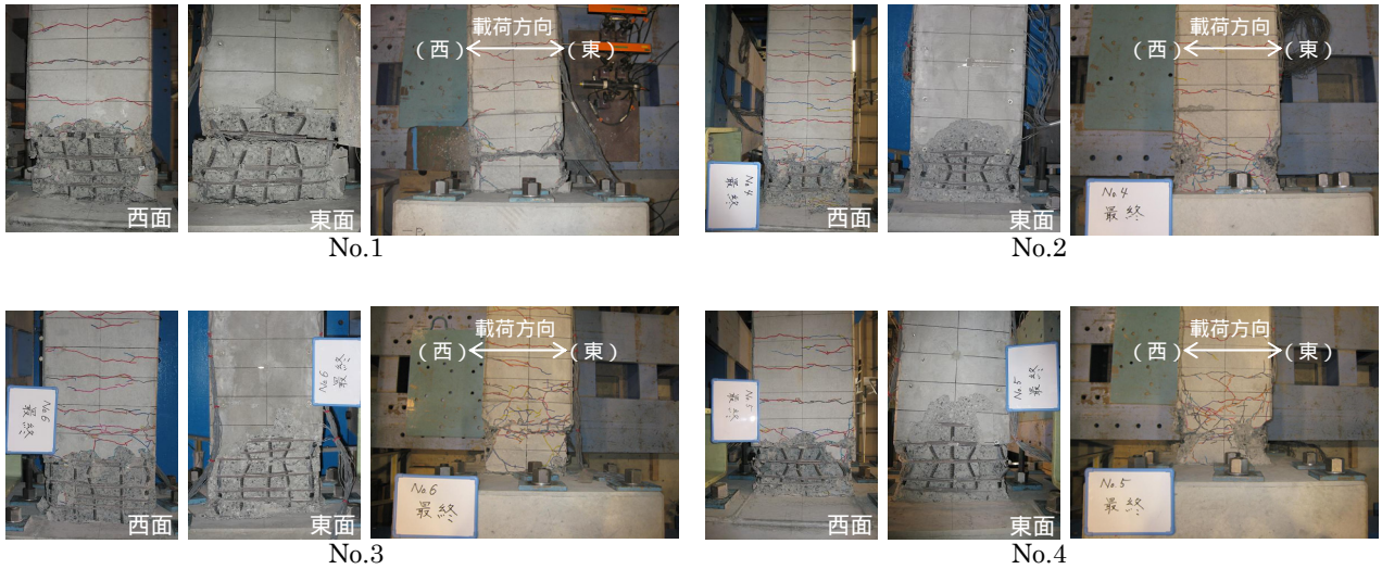
写真 - 1 最終損傷状況
