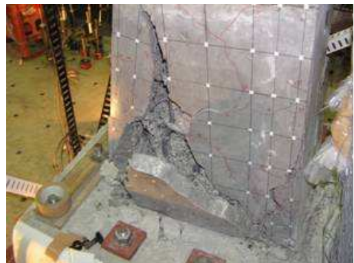
写真-1 かぶりコンクリートの剥離状況 (No. 3-1)
