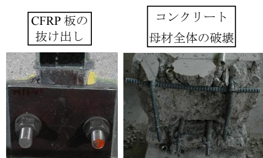
写真-4 破壊状況
