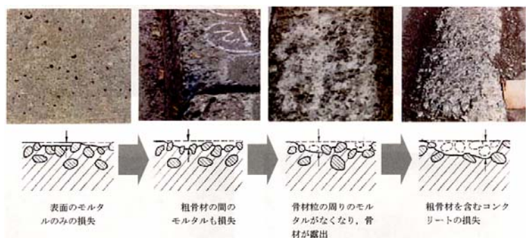
図-1 道路縁石のスケーリングと進行模式図
