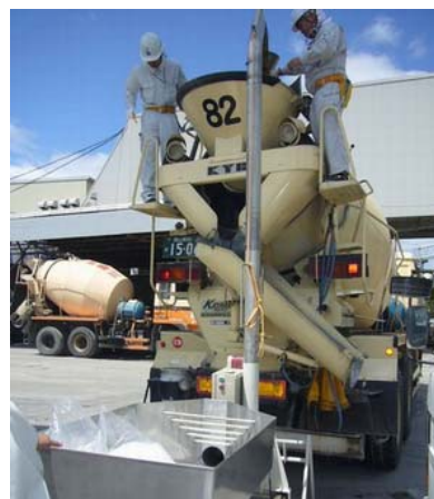
写真-3 繊維投入機によるアジテーターカーへの繊維の添加状況
