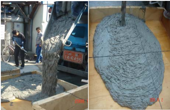
(c) 運搬および吐出 (d) 部材への打込み
