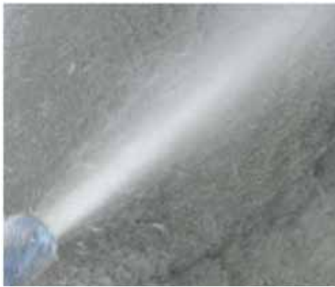
写真-2 吹付け状況
