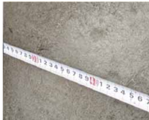
写真-3 吹付け後の状況
