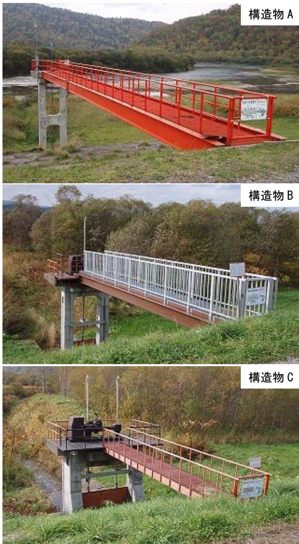
図-3 対象構造物（河川樋門）
