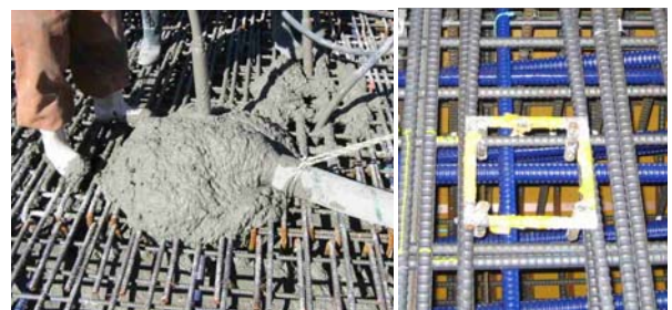
写真-1 鉄筋上に山になったコンクリート(左)とホースを挿入するための開口部の例(右)
