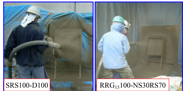
写真 - 2 吹付け状況の例
