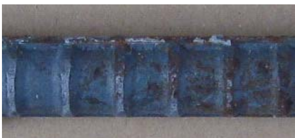
写真-2 腐食状況例 (4ヶ月暴露後A)
