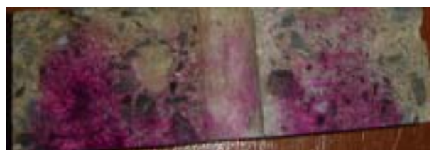
写真-3 ひび割れ幅0.082mmの含浸材の浸透状況
