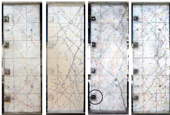
図-8 ひび割れ性状 (変形角1/50 載荷後)
