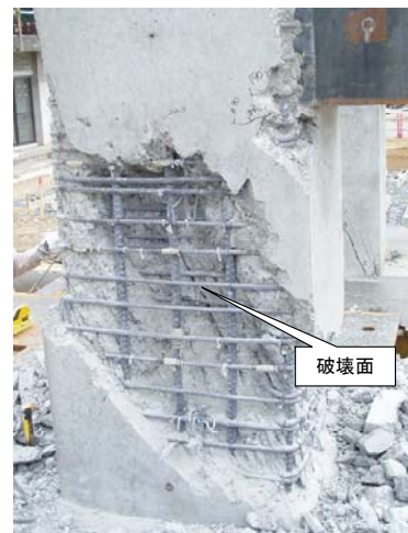
写真-3 No.3 試験体の破壊面
