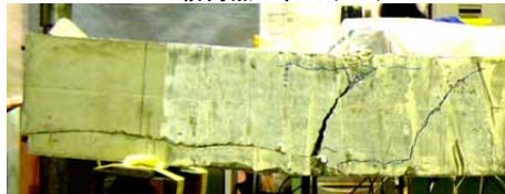
SRF補強供試体終局(シートを剥した状態)
