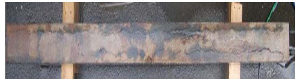
図-4 腐食ひび割れ図
