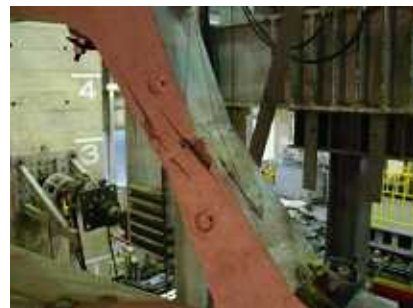
構面 3 層内部から撮影
