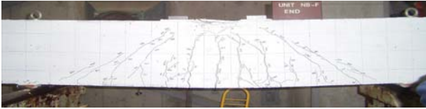
写真-2 破壊状況 (NB-F)
