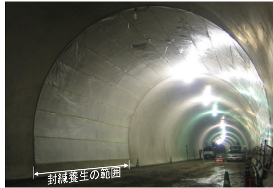
図-9 トンネルでの養生状況 (1スパンのみ)
