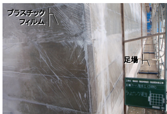
図-2 防波堤ケーソンでの養生状況
