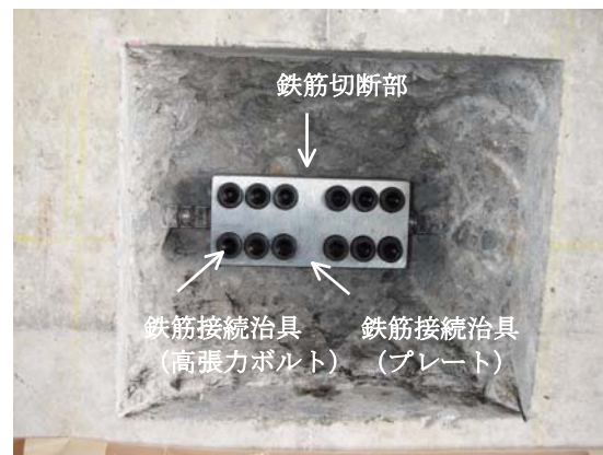
図-4 鉄筋接統治具による修復状況
