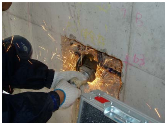
b. 鉄筋の切断
