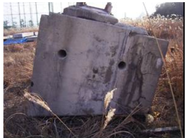
写真-1 切断したコンクリートブロック (中央の 2 孔は貫通コア採取箇所)
