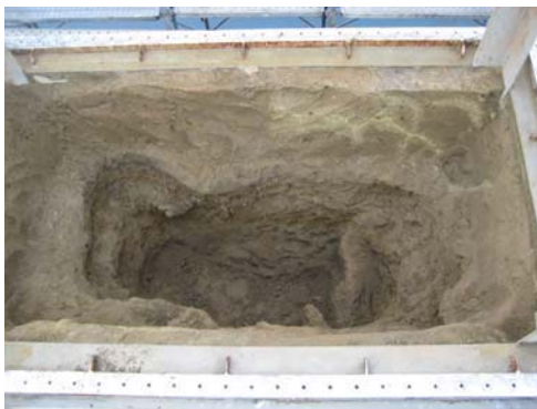
写真-8 1次注入体の露頭状況
