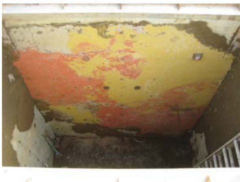
写真-9 界面注入体の露頭状況
