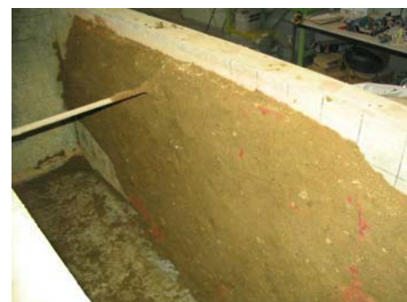
写真-7 1次+2次注入した注入試験(ケース5)
