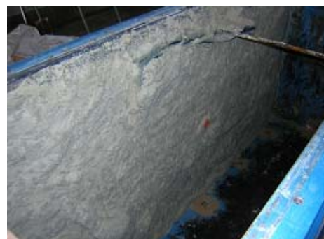
写真-3 注入終了後の背面注入状況(ケース1)
