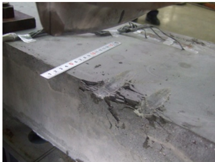
図-12 充実側直角載荷での損傷状況
