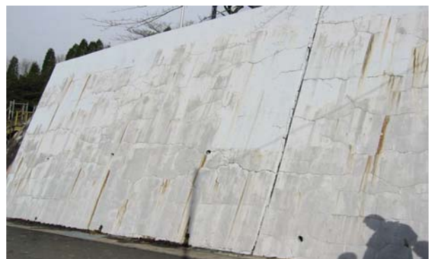
写真-1 施工前の擁壁
