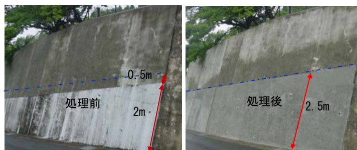
写真-3 WJによる表面処理前・後の状況
