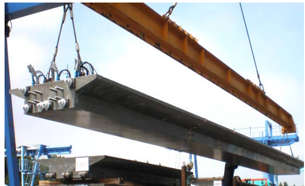
写真-1 橋梁部材
