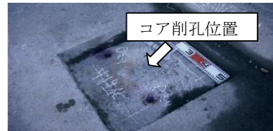
写真-1 塩化物イオン濃度調査(床版上面)
