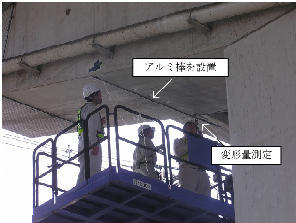
写真-1 変形計測状況
