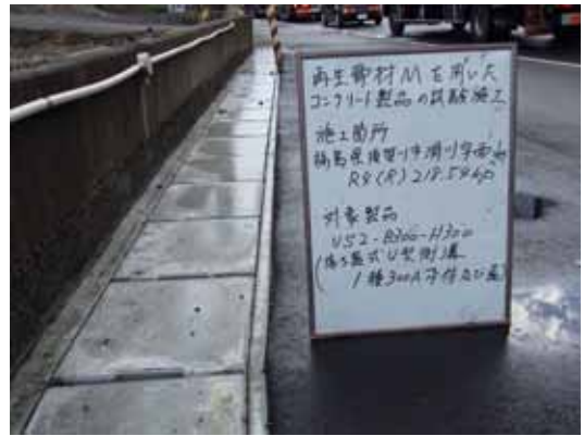
図 - 12 製品の設置状況
