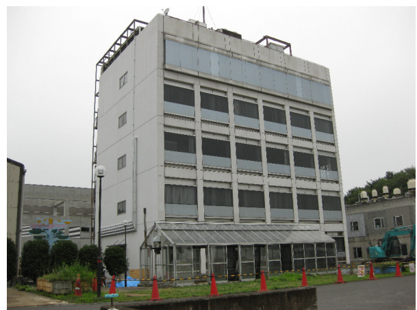
写真 - 1 解体建物の概要
