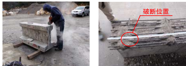
(a) はつり出し状況
