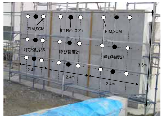
写真 - 1 実大RC壁 (R) と透気性測定位置
