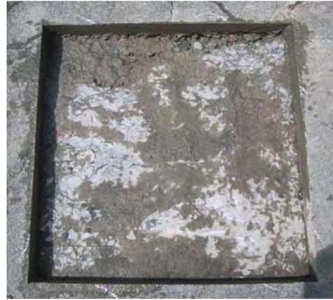
写真-2 舗装撤去後の床版上面の劣化状況
