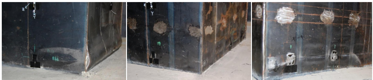
試験体 A 曲げ圧縮部
