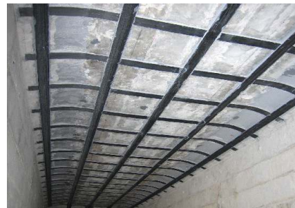
写真-1 CFRPプレート補強適用事例
