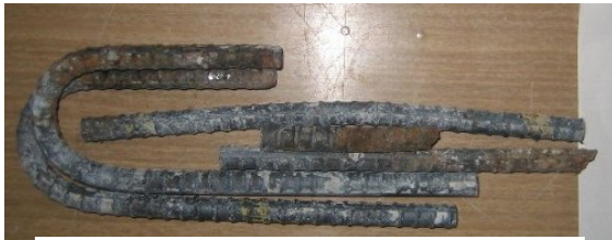
写真-2 鉄筋腐食状況の一例
