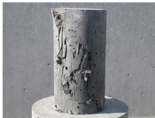
図-10 圧縮供試体の破壊状況
