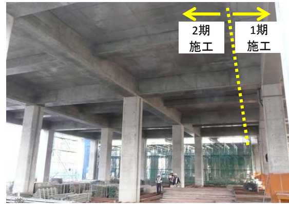
写真-1 尿素コンクリート適用構造物の概要
