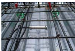
写真-1 ひずみゲージ設置状況
