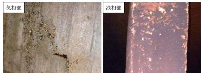
写真-1 脆弱化状況
