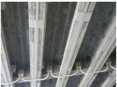
(g) PC 橋への電気防食の適用事例 (プレテン T 桁)
