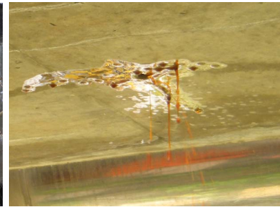
(f) ドリル削孔後の水の噴出状況 (プレテンスラブ桁)
