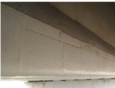
(h) 炭素繊維シートによる補強事例 (ポステン T 桁)
