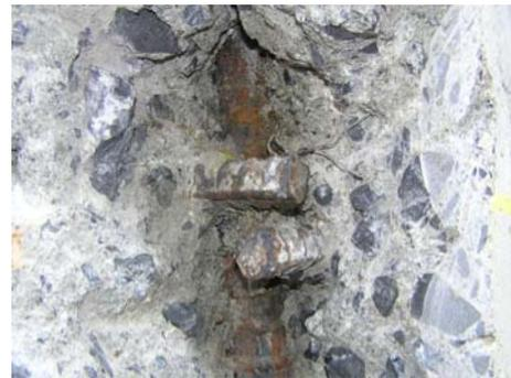
写真-3 橋脚柱隅角部のはつり状況 (B 橋)
