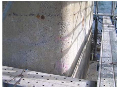
写真-1 橋脚柱隅角部のひび割れ状況 (A 橋)
