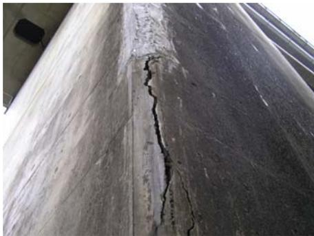
写真-2 橋脚柱隅角部のひび割れ状況 (B 橋)
