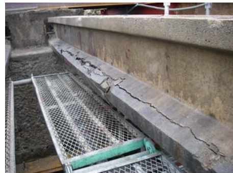
図-1 解体時の鱗崎橋の外観状況 (D桁)
