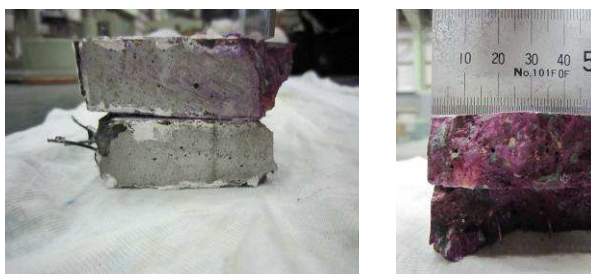
加熱面 割裂面 写真-6 フェノールフタレイン塗布
