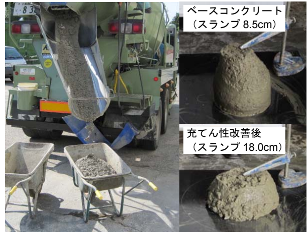
写真-3 コンクリート排出状況およびスランプの状況
