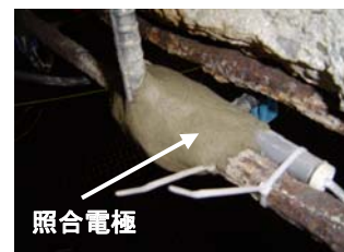
図-2 梁部における照合電極の設置状況
