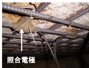
図-1 床版部における照合電極の設置状況
